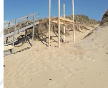
Reparation av trappa vid Råbocka.
